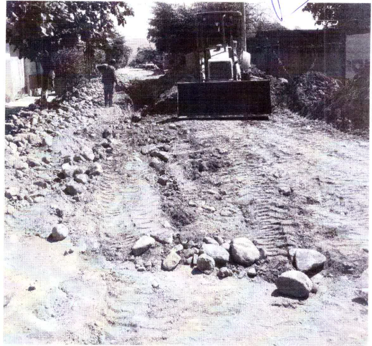
Imagen 7. Relleno de zanja donde se realizaron los trabajos de reposición de tubería
