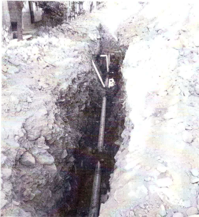
Imagen 6. Reposición de descargas domiciliarias.
